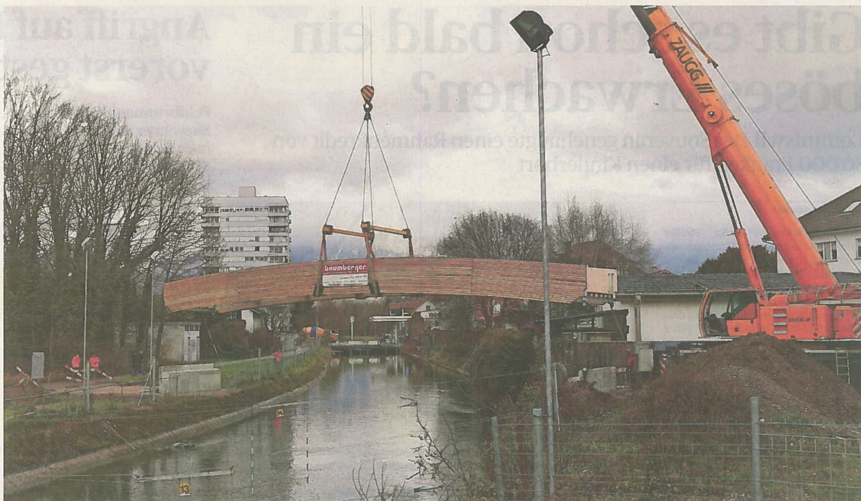
Präzisionsarbeit: Vorsichtig wird die Brücke mit einem Hub auf die Brückenelemente über der Emme angebracht.
